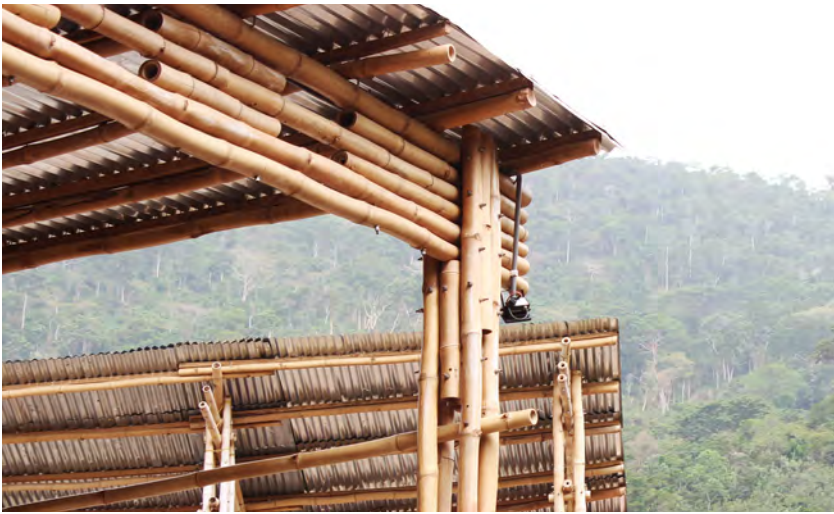
Dachkonstruktion / roof construction
