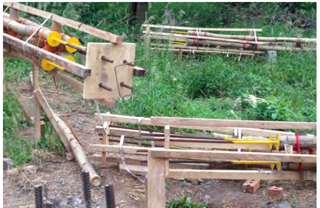
Bambusarbeiten / bamboo construction
