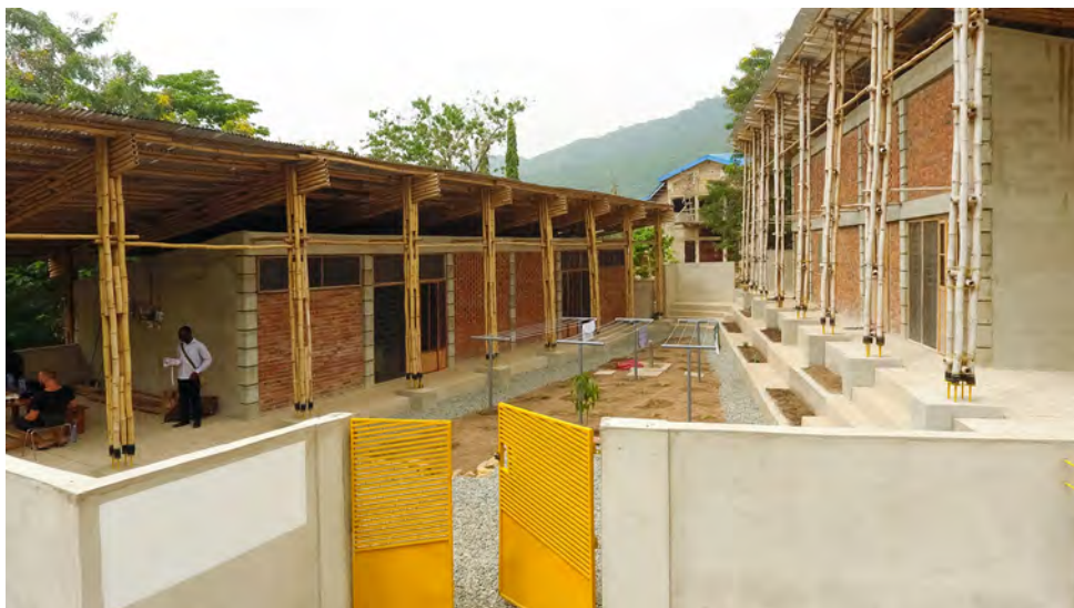
Hof mit Eingangsbereich / courtyard with entry area
